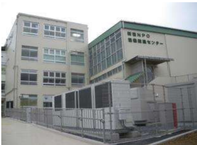
(新宿 NPO 協働推進センター) ※西戸山第二中学校統合後の跡施設を 活用して設置
