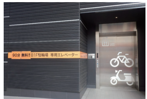
新宿東宝ビルの地下駐輪場入り口
