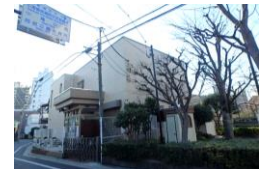
小滝橋地域防災活動拠点
