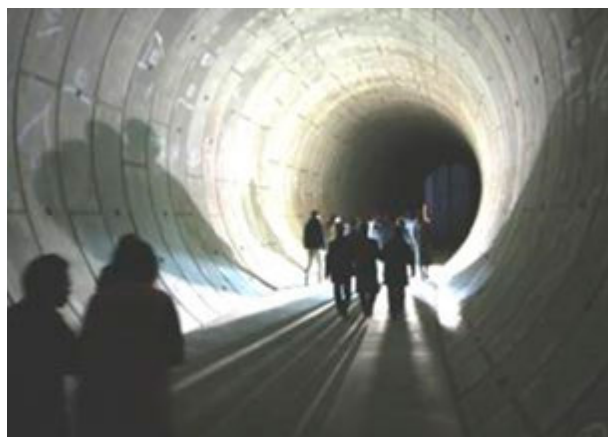
トンネル内部
