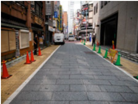
保水性舗装の施工状況(西新宿一丁目地区)
