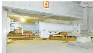
油の粘性を利用して地震の揺れを抑えます。地震の規模に応じて、揺れを抑える力を変化させ、建物の変形を小さくします。
