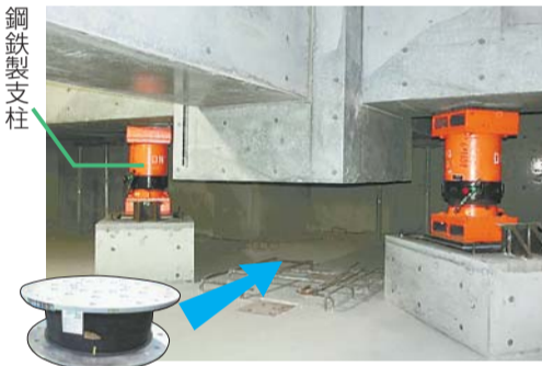
免震装置の取り付けイメージ
