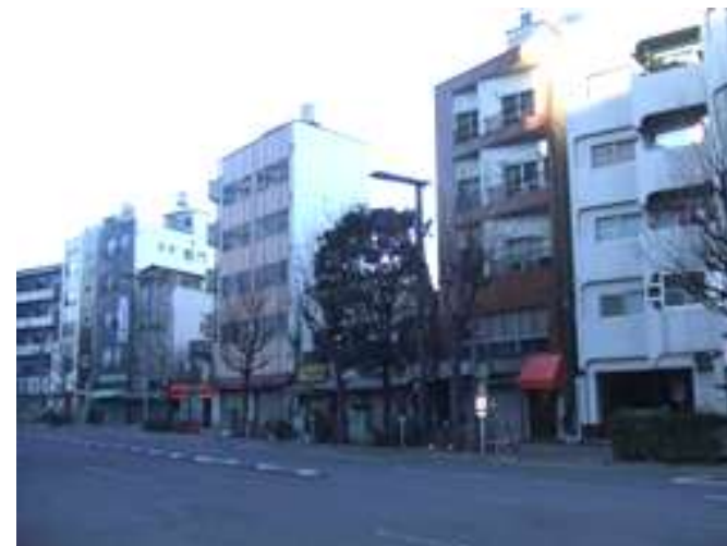
① 十二社通り沿い建物 (店舗、事務所、賃貸住宅) ・青梅街道と十二社通り沿道は老朽化した旧耐震の耐火建築物が多い。
