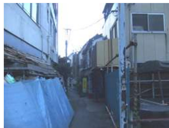
③ 地区の狭隘道路 ・地区内部は低層の老朽木造建物が多い。
