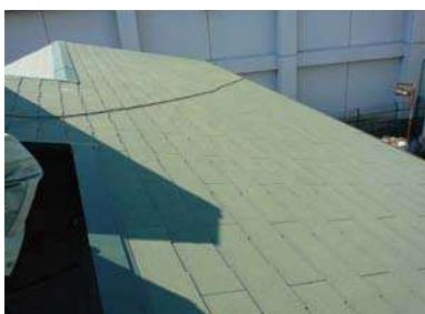
屋根の軽量化は、耐震化の上で比較的手軽で効果のある方法です。建物の上方を軽くすることで、揺れを少なくして建物の倒壊を防ぎます。
