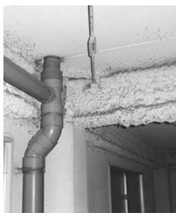
梁・天井に付着したアスベスト
