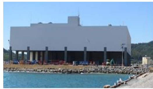
処理後（平成 24 年 9 月 26 日）
