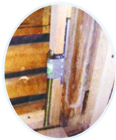
基礎と柱を固定する「ホールダウン金物」
