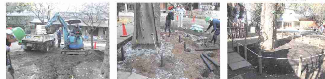
覆土の撤去 → 土壌改良 → 人止め柵新設
