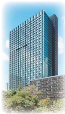
西新宿8丁目成子地区市街地再開発のオフィス棟と住居棟
