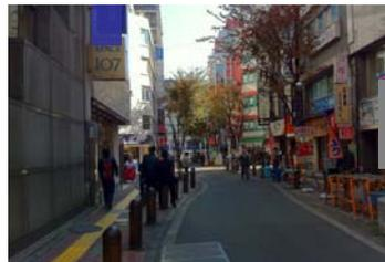
車道を蛇行させることで車のスピードを抑制し、歩行者の安全性を高めている（新宿駅西口プラザ通りコミュニティ道路）
