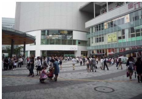
再開発で作られた広場と歩道を一体的に整備することで、ゆったりとした歩行空間をつくり出すことができる（有楽町）
