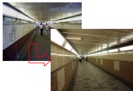
薄暗く、夜間の通行に危険を感じるガード下を明るく清潔な空間に改善している
