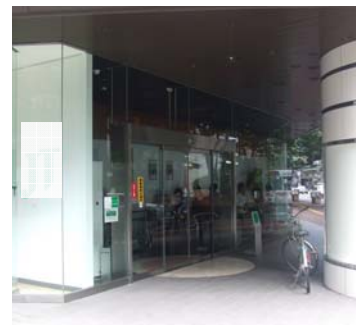
民間施設の1階を喫煙ルームとして一般に開放し、受動喫煙を防止している（福岡市）
