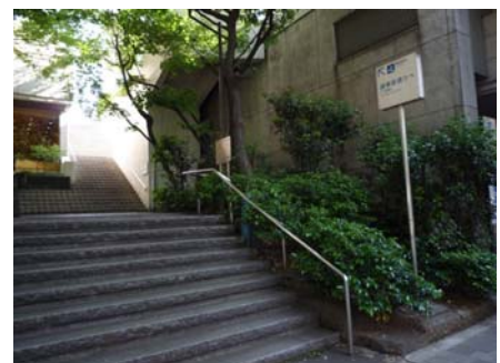
立体交差移動用の階段が多く、バリアフリー経路になっていない
