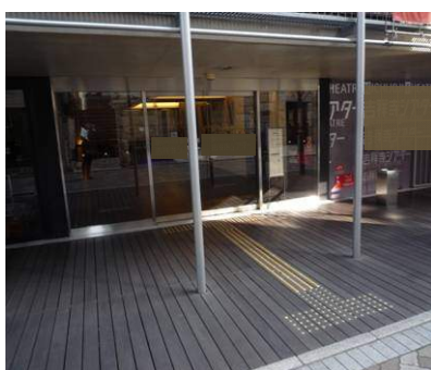
主要な出入口は十分な間口を確保し自動ドアや引き戸にすることで、車いすでも容易に出入りすることができる
