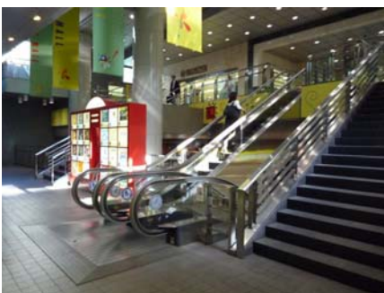
地下通路からのビル出入口の多くは高低差が生じており、エスカレーターが設置されているが、エレベーターがないため、バリアフリー経路になっていない
