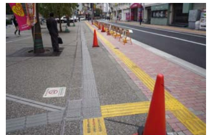
道路と建築物で異なる時期に敷設された誘導用ブロック
