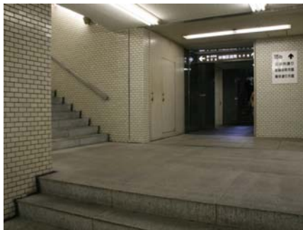
地下通路に連結する沿道のビルの通路に高低差があり、車いすでは通行できない場合がある
