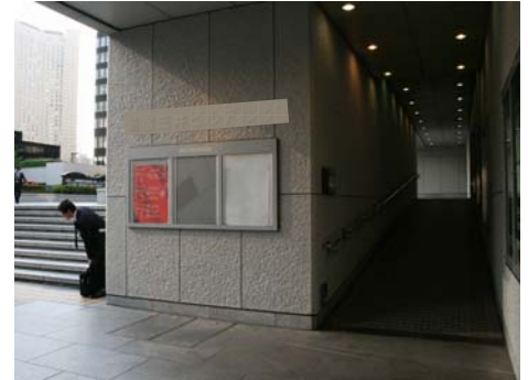
スロープと階段が離れており、スロープが認識しにくくなっている
