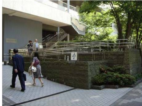
スロープを後から設置したため、折り返しが多く使いにくくなっている
