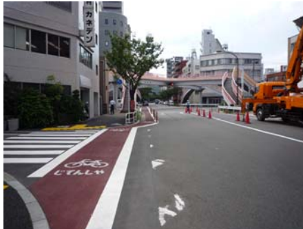
自転車の専用通行帯（自転車レーン）を設置し歩行者と自転車を分離することで安全性を高めることができる（JR 大森駅周辺）
