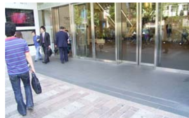
道路と段差のないフラットなエントランスとすることで、建築物にスムーズに出入りできる
