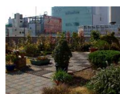
新宿区役所本庁舎 屋上
