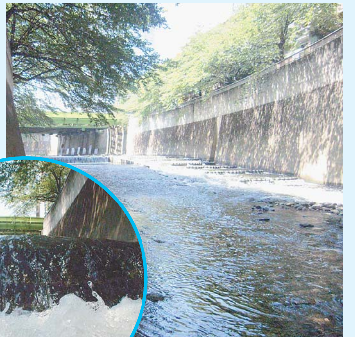
右側の低い段差を魚がのぼります 魚道の拡大写真
