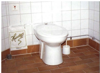
尿分離乾燥システムのトイレブース
