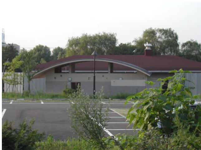
水元公園トイレ
