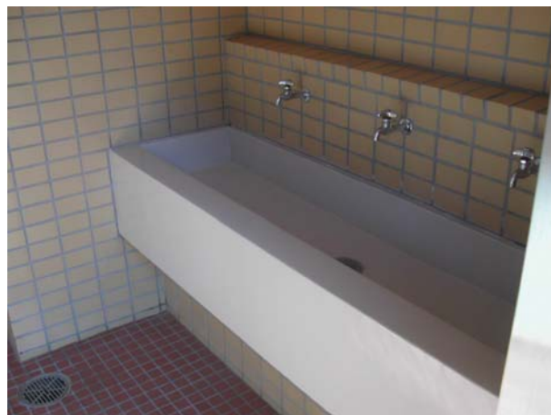
ブース人研：塗装・落書保護コーティング、床タイル：高圧洗浄・中和洗浄・防汚コーティング 壁：高圧洗浄・中和洗浄・落書保護コーティング、天井：高圧洗浄・吹付タイル、和便器：洋便器 に交換等
