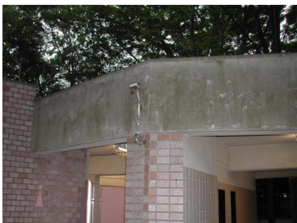
外壁打放：高圧洗浄・ウレタン塗装 外壁タイル：高圧洗浄・中和洗浄・落書保護コーティング
