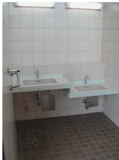
武蔵野公園トイレ
