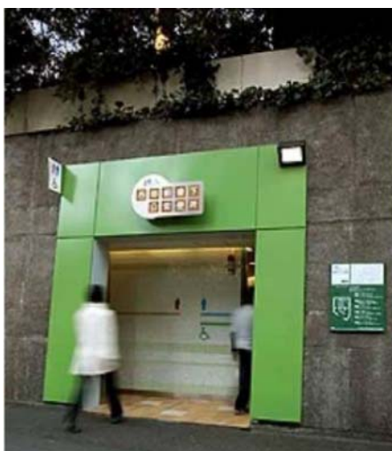
視認性の高いトイレ入口
