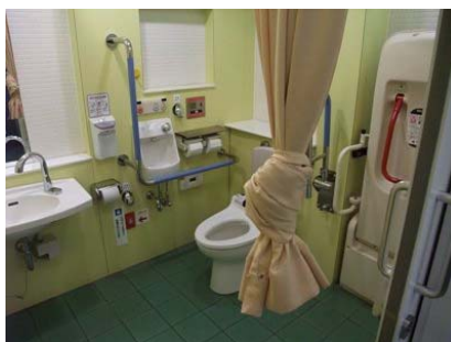
男子トイレ内の「誰でもトイレ」 （オストメイト対応）
