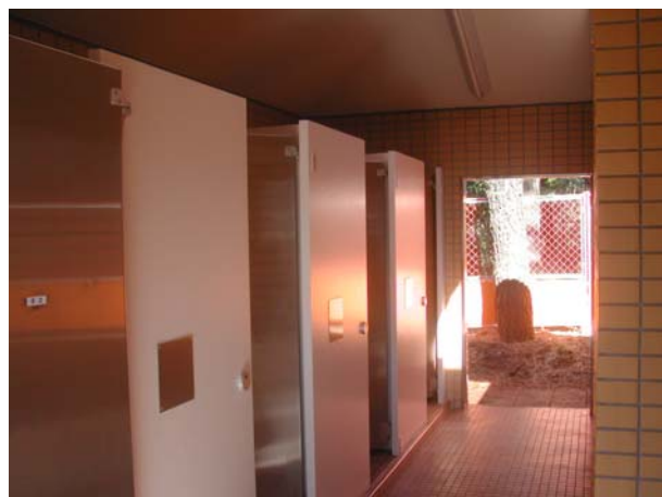
ブース人研：塗装・落書保護コーティング、床タイル：高圧洗浄・中和洗浄・防汚コーティング 壁：高圧洗浄・中和洗浄・落書保護コーティング、天井：高圧洗浄・吹付タイル、和便器：洋便器 に交換等
