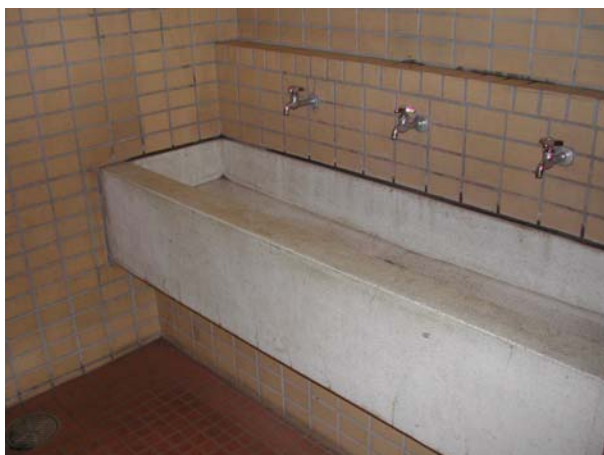
手洗い人研：塗装 壁：高圧洗浄・中和洗浄・落書保護コーティング
