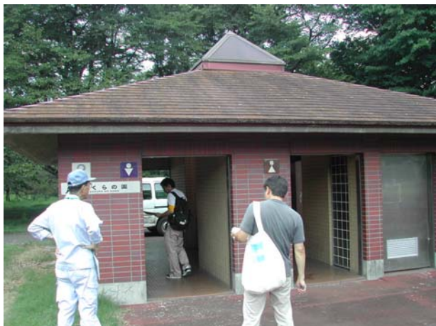
屋根コロニアル：高圧洗浄・シリコン系塗装 外壁タイル：高圧洗浄・中和洗浄・落書保護コーティング
