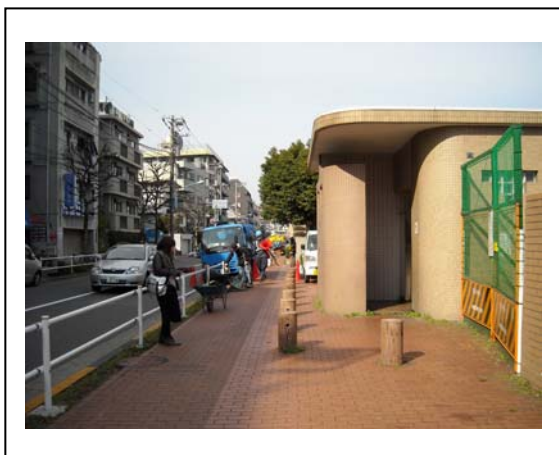
上落合公衆便所
