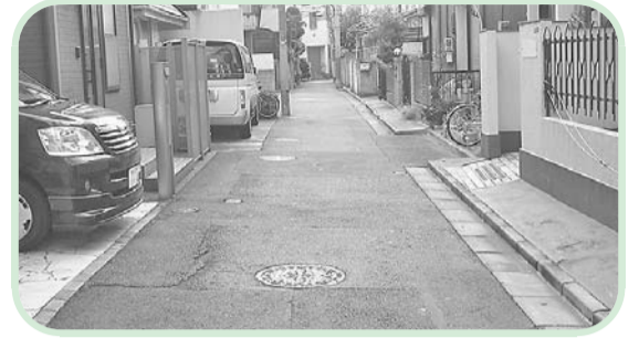
拡幅した道路
