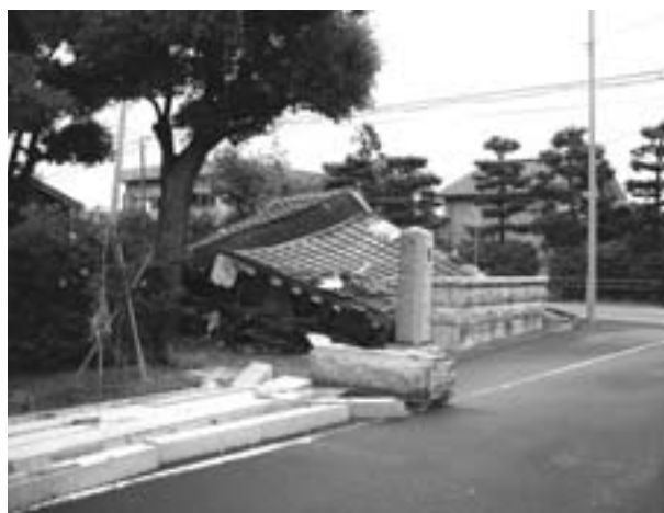
新潟県中越沖地震（平成19年7月）における被害状況
