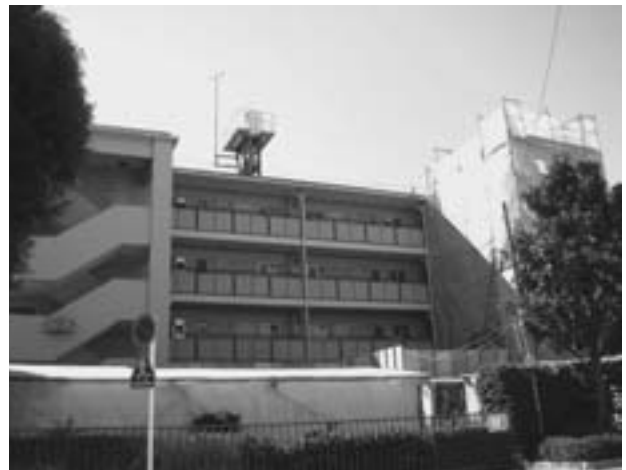
地域住宅交付金を活用してエレベータを設置する区営戸山一丁目アパート
