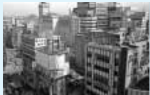
新宿西口でビルラッシュ(昭和43年)
