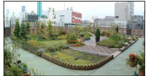
<区役所本庁舎の屋上緑化見本園>
