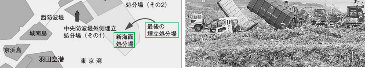
東京港最後の埋立処分場
