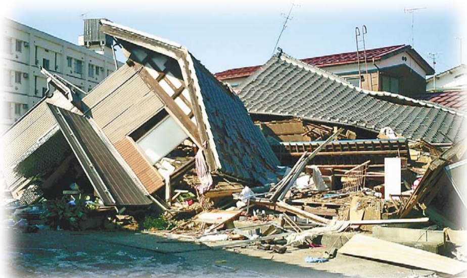
新潟県中越地震(平成16年)で被害を受けた住宅
