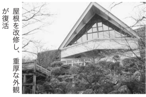
屋根を改修し、重厚な外観が復活
