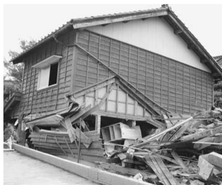
新潟県中越沖地震で倒壊した家屋
