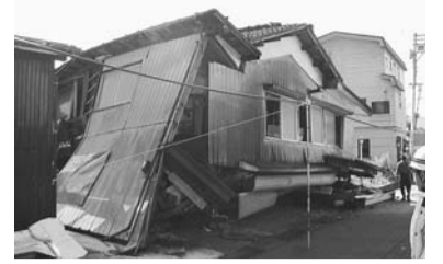
新潟県中越地震で被害を受けた住宅
