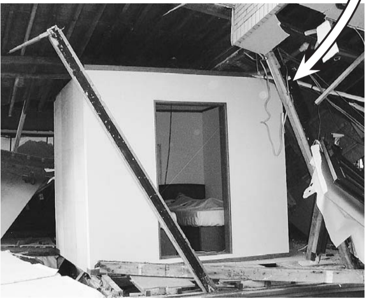
木材・鉄骨できていて、部屋に安全な空間を確保します
